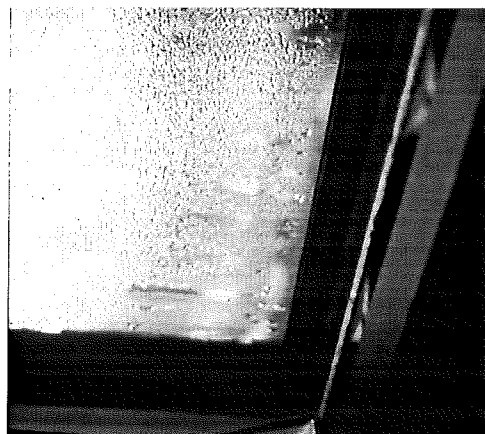
Condensation sur une fenêtre
